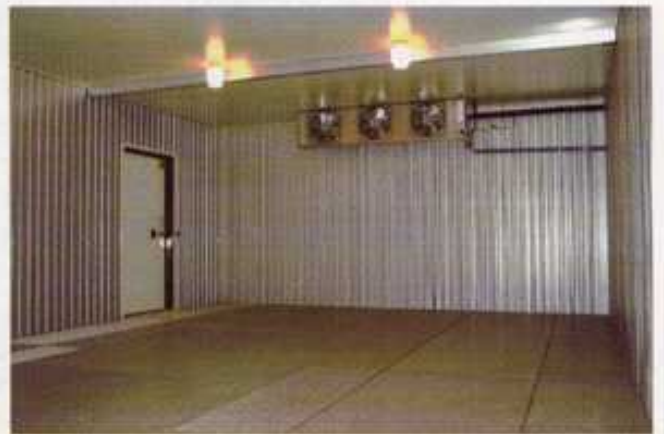
大型特殊冷蔵庫。自社設計で、温度高低差はわずか±0.5℃以内だという。物流センター内にも基あり、業界初の水溫保管を実施している
